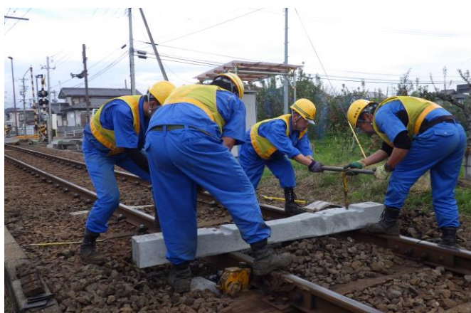
PC 枕木化工事
