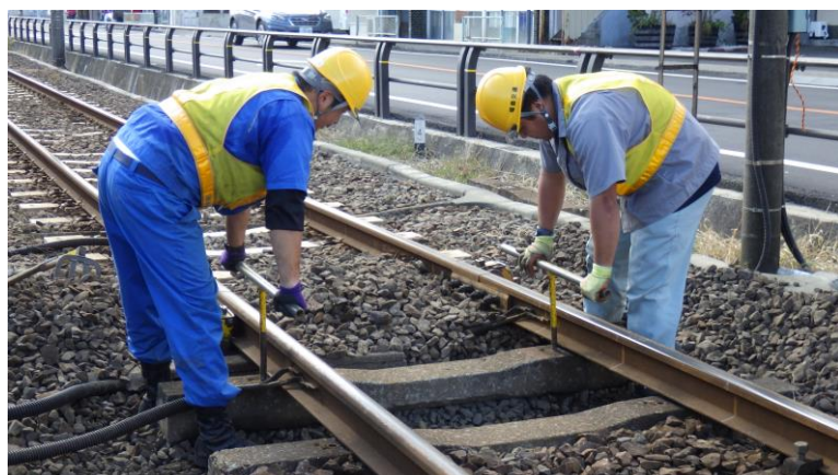
PC 枕木化工事
