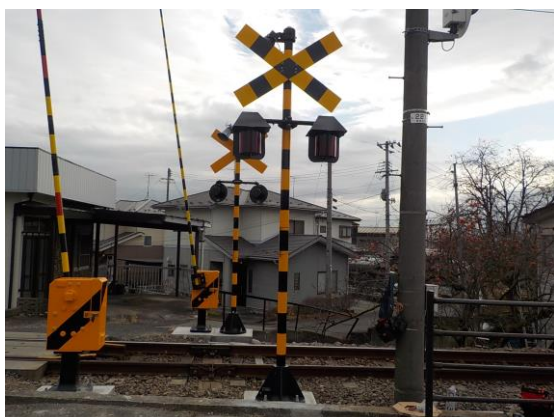
踏切保安装置更新工事(境田踏切)
