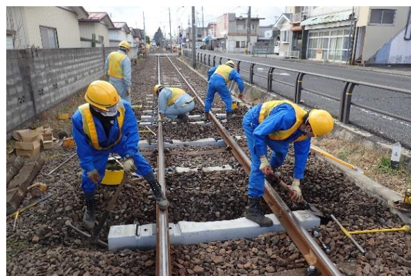
PC 枕木交換工事(笹谷～桜水間)
