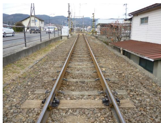
重軌条化工事(医王寺前～花水坂間)
