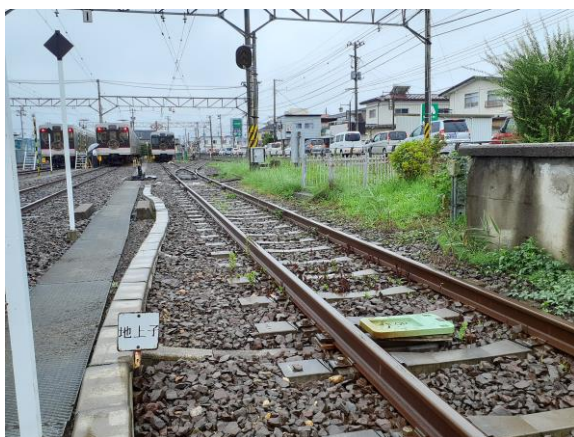
ATS（自動列車停止装置）
