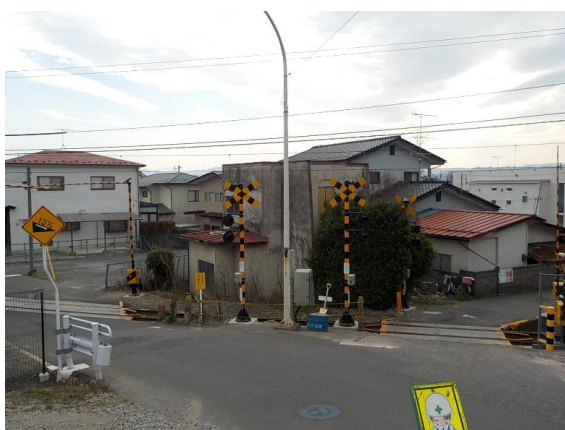
踏切保安装置更新工事(西坂下・花水坂踏切)
