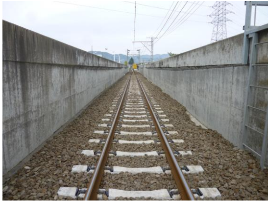
枕木交換工事
