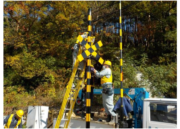
踏切保安装置改良工事
